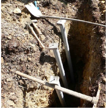
Obr. 2: Výkop o hloubce 135 cm, pasti jsou umístěny a připraveny k zahrnutí (foto I. H. Tuf).
